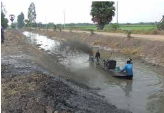
ขุดลอกเปิดทางน้ำในคลองส่งน้ำ ในปี พ.ศ.2555
